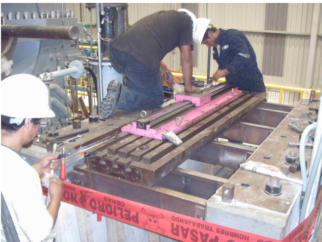
Fuente: P4282992.JPG Se instaló una sólida base auxiliar para la fresadora
