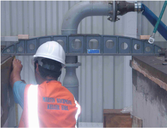
Fuente: P4252916.JPG Comprobando el estado previo al maquinado
