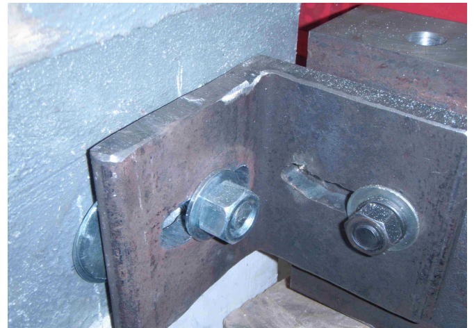
Fuente: P4272963..JPG Detalle articulación fijación puente
